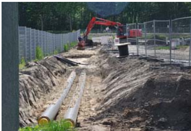
Energie-Pipeline (4,5 km zum Flughafen und AirportPark FMO)
